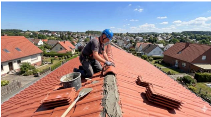
11.04.2026 - Firstziegel-Montage
