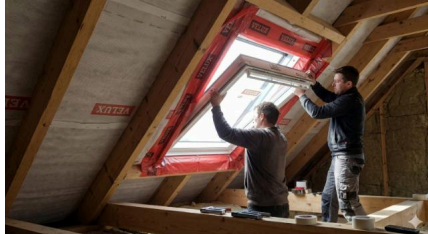
09.04.2026 - Velux Dachfenster eingebaut
