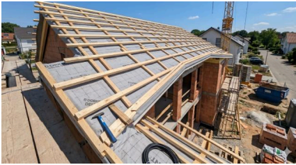
07.04.2026 - Lattung OG fertiggestellt
